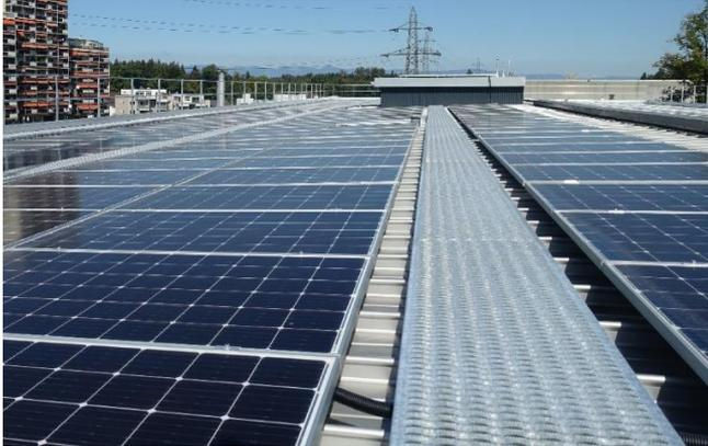
**ROOFWALK** Wartungsstege zwischen PV-Modulen
