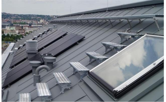
**ROOFSTEP** Stufen für Dächer > 20° Dachneigung
