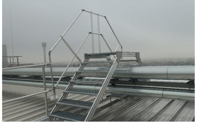
**ROOFCROSS** zum Übersteigen von Rohrleitungen und Attiken
